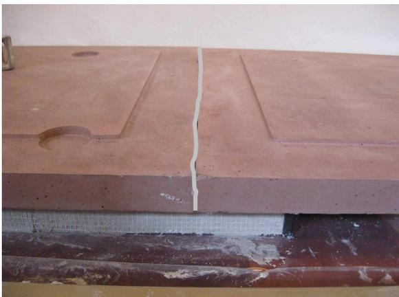
Zwischen den beiden Platten muss eine Fuge mit Hafnerflex aufgetragen werden.
