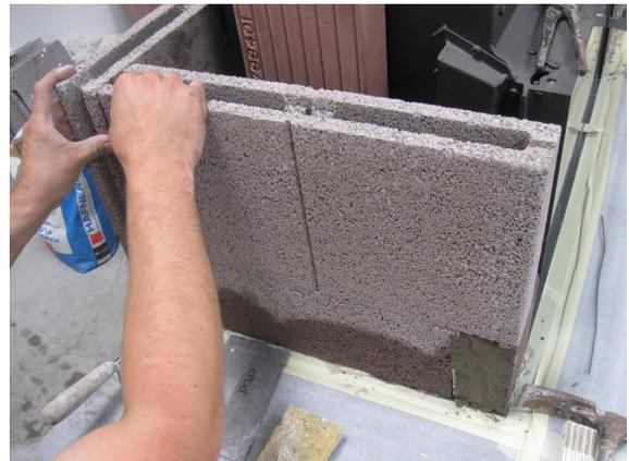
Die 3. Reihe nach Verlegeplan aufmauern. LilaTec-Steine mit der Vergussmasse bis zur Hälfte ausgießen.
