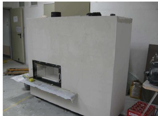
Nachdem Hafnerflex mit Textilglasgitter angetrocknet ist, sollte die Anlage probegeheizt werden.
