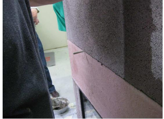
5. Reihe fertig mauern und mit der Vergussmasse bis zur Hälfte ausgießen.
