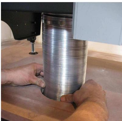
Flexschlauch in die Bodenausnehmung durchführen.
