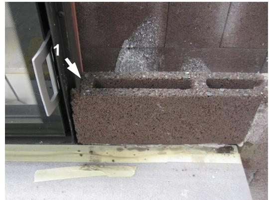
1. Auch auf der zweiten Seite ist der hintere Steg des Zwischenwandsteines zu entfernen.
