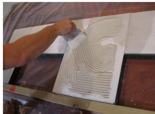
Auf den Sockelsteinen Hafnerflex für die Bodenplatten auftragen.
