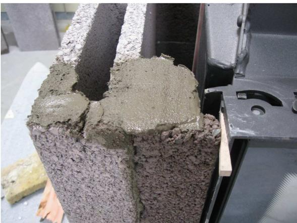
Haftmörtel-Kontaktschicht links und rechts neben Anbaurahmen auftragen.
