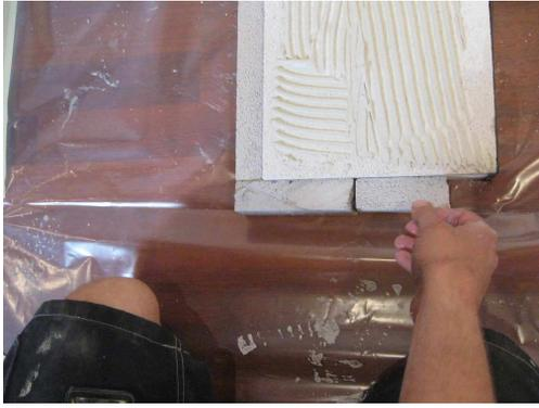
**TIP:** Aus den Sockelsteinresten 35 mm breite Stücke zuschneiden und am Sockel aussen anlegen. Sie dienen zum Ausrichten der Bodenplatten.
