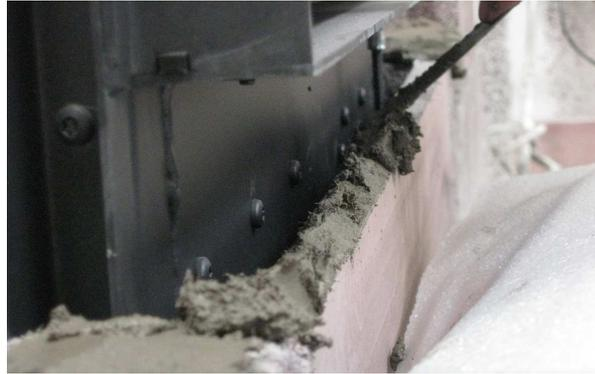
✦ Mit Haftmörtel eine keilförmige Schicht auftragen
