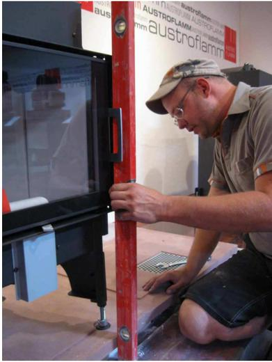
Kamineinsatz mittels Wasserwaage ausrichten.
