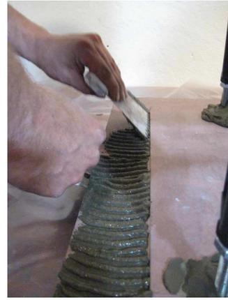
Haftmörtel Kontaktschicht für die erste LilaTec-Steinreihe mit einer Zahnpachtel auftragen.
