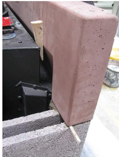
Nach dem Ausrichten, Sturz mit Holzkeile fixieren.
