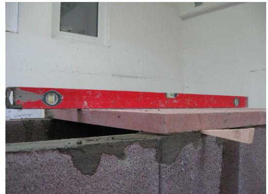
Deckelplatte ausrichten und mit Keile fixieren.
