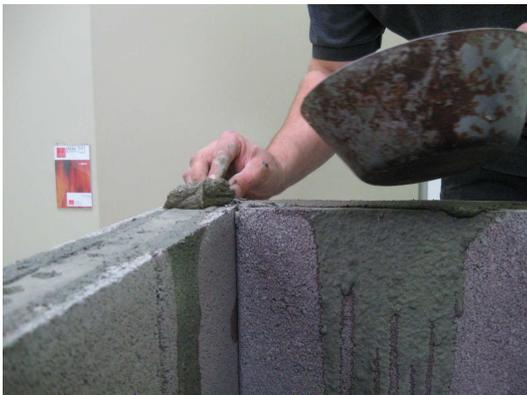
Eine Haftmörtel-Kontaktschicht für die Deckelplatten auftragen.
