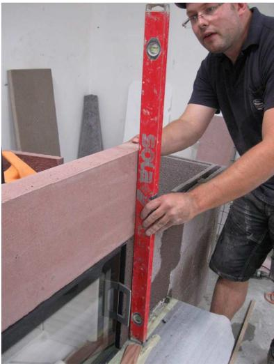
Sturz mit Wasserwaage ausrichten.
