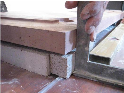
Bodenplatte mit Winkel bündig zur Anschlaghilfe ausrichten.
